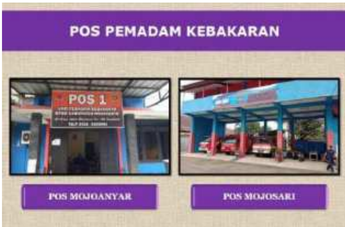
Gambar 2.3 Pos Pemadam Kebakaran
